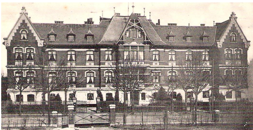
Figure 1: Historisches Foto des Hauptgebäudes in der Martinistraße (aus: Bethanien Hochbaulich-freiraumplanerischer Realisierungswettbewerb, S. 8).
